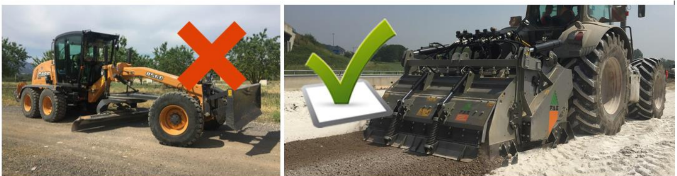
Figura 3. La nivelación a Motor no Homogeniza, ni Estabiliza, ni recicla.
